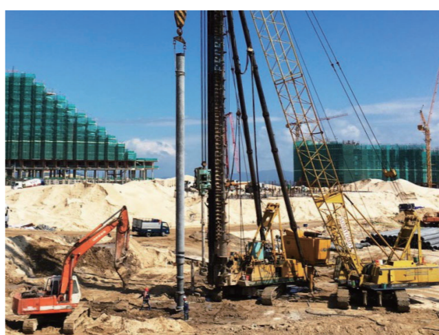
ベトナムにおける既製コンクリート杭の施工風景
