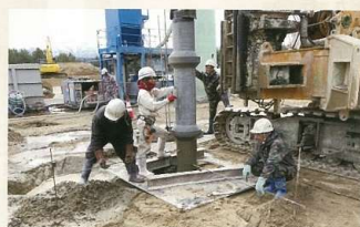
写真-2 既製コンクリート杭の施工業務の状況
