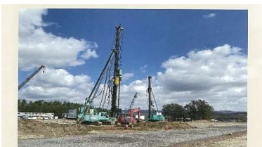
写真-1 杭工事の様態状況の全景
